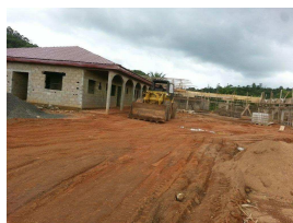
Il seminario in costruzione.
