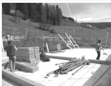
Immagine del cantiere della casa del Campo Rangers.
