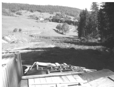
Lo scavo lato torrente.
