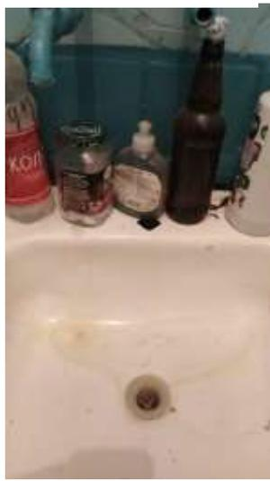
E' visibile l'alone marrone che l'acqua di rete lascia sui sanitari dopo il suo passaggio. Ciò indica la scarsa qualità della fornitura idrica
